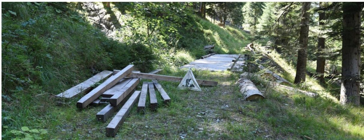
Abbildung 12: Nicht befahrbare Brückenkonstruktion im oberen Teil des Verzascawaldes.
