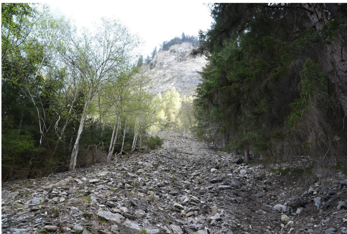
Figure 2 : Le « Caseler-Tobel » dans la partie supérieure du Verzascawald , avec vue sur une source potentielle de chutes de pierres en haut de l'image.
